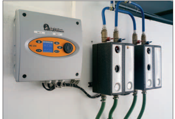
Klimapočítač MC 235 k řízení celého stájového klimatu a třístupňová regulace pro vodní vytápění.
